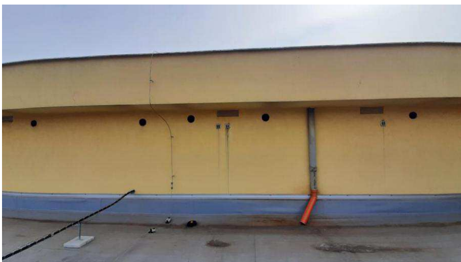
Obr. č. 6: Otvory po nefunkčním odvětrání učeben na severozápadní straně budovy katedry
