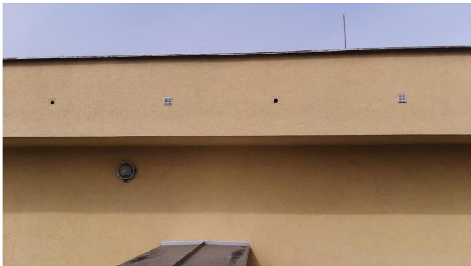
Obr. č. 5: Chybějící mřížky na nejvýše položené atice střechy budovy katedry z jihozápadní strany
