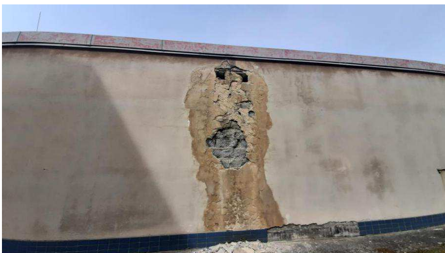
Obr. č. 7: Rozsáhlé poškození omítky na jihozápadní straně auly
